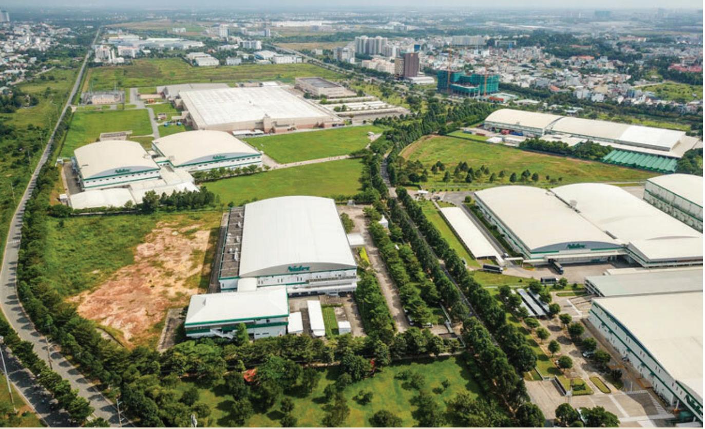
Toàn cảnh Khu Công nghệ cao Thành phố Hồ Chí Minh. Nguồn: Cổng thông tin điện tử Chính phủ.
