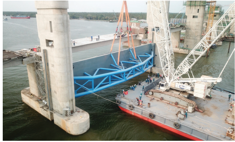
Biện pháp thi công công trình bằng hệ nổi được áp dụng vào công trình cống Cái Lớn.
