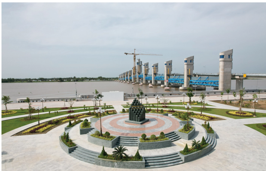
Công trình cống Cái Lớn thuộc hệ thống thủy lợi Cái Lớn - Cái Bé.
