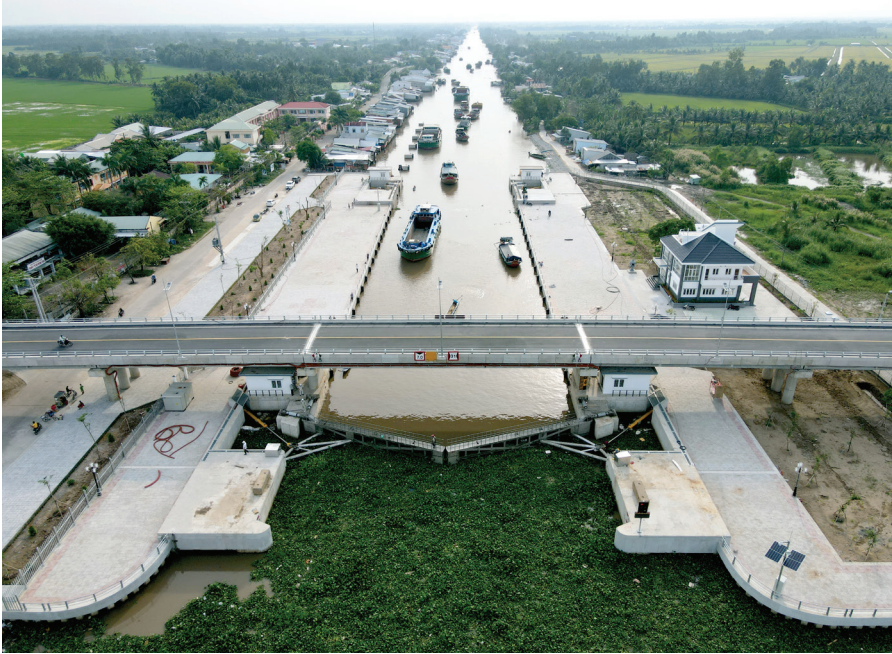
Công trình cống Xèo Rô khi hoàn thành.
