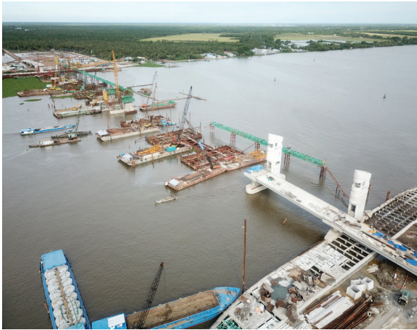
Biện pháp thi công công trình bằng hệ nổi được áp dụng vào công trình cống Cái Lớn.
