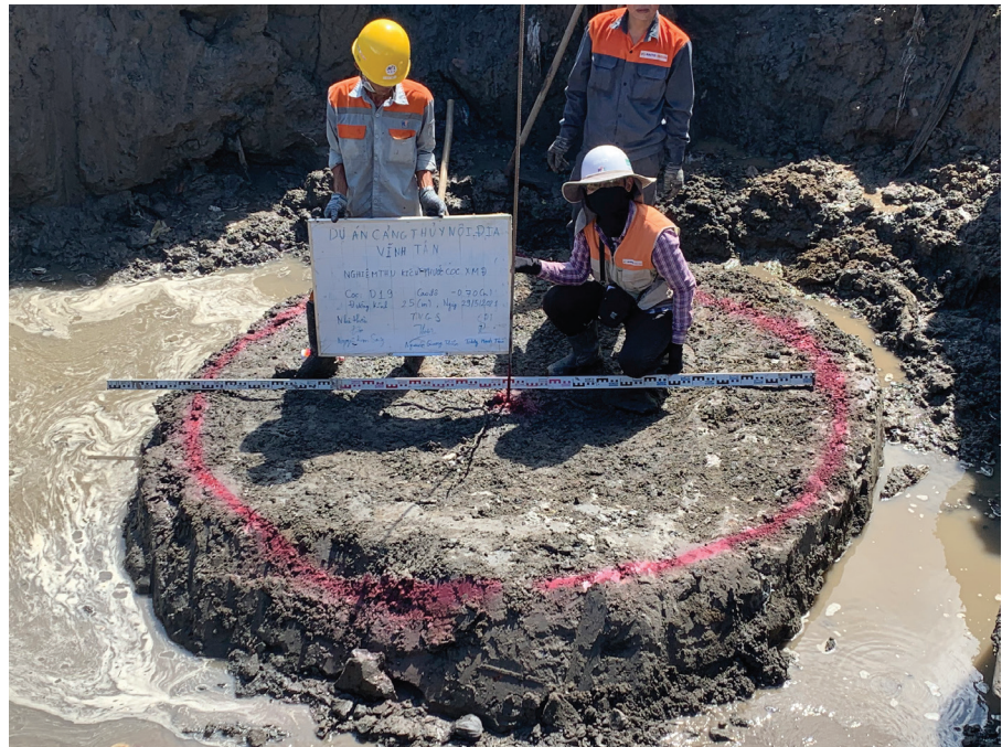
Thi công dự án Cảng thủy nội địa Vinh Tân.
