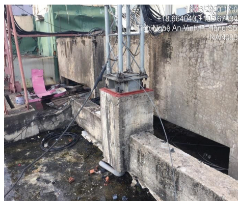
Hiện trạng dầm móng một số trạm viễn thông bị xuống cấp, cốt thép bị ăn mòn dẫn đến làm nứt vỡ và phá huỷ kết cấu BTCT của dầm móng.
