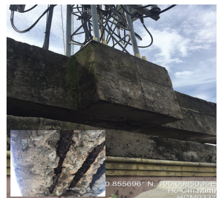
Hiện trạng dầm móng một số trạm viễn thông bị xuống cấp, cốt thép bị ăn mòn dẫn đến làm nứt vỡ và phá huỷ kết cấu BTCT của dầm móng.
