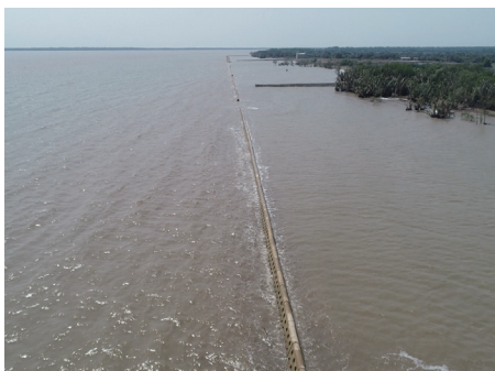
Đê giảm sóng kết cấu rỗng tại Tiền Giang.
