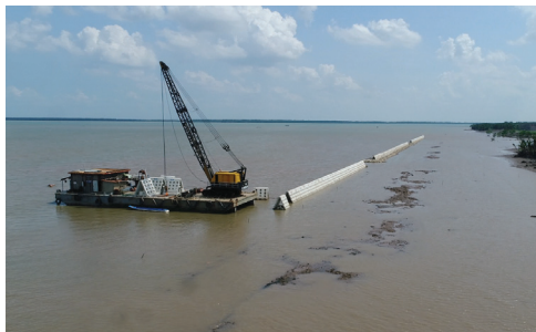
Quá trình vận chuyển và thi công đê giảm sóng kết cấu rỗng.
