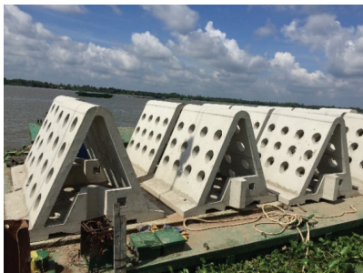
Quá trình vận chuyển và thi công đê giảm sóng kết cấu rỗng.
