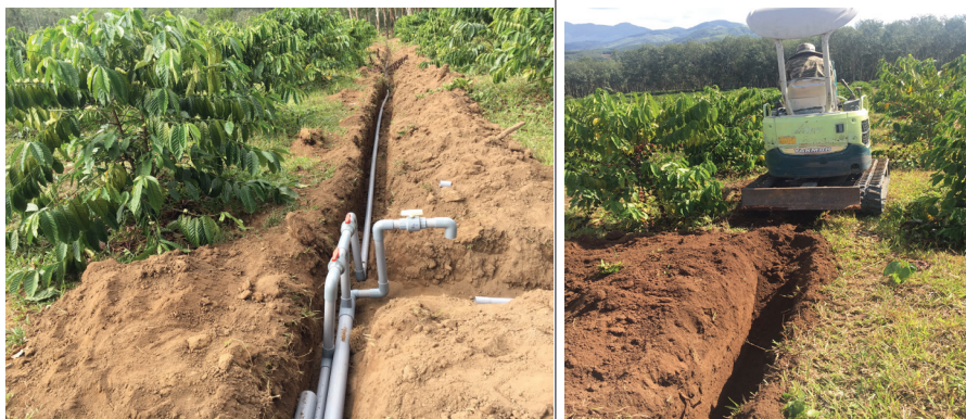
Lắp đặt hệ thống tưới tiết kiệm cho mô hình cà phê tại Kom Tum.
